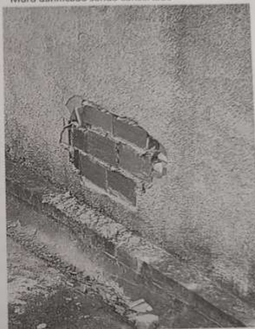
Muro danificado sendo consertado
