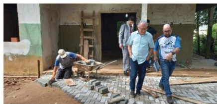
Dr. Laércio Ribeiro acompanhando as obras de recuperação do Numa e do Areão.
