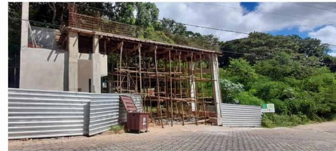
Portaria principal está sendo concluída, enquanto a portaria do Sítio já teve início.
