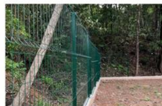
As obras de cercamento seguem a pleno vapor o que garantirá mais segurança e proteção ao parque.
