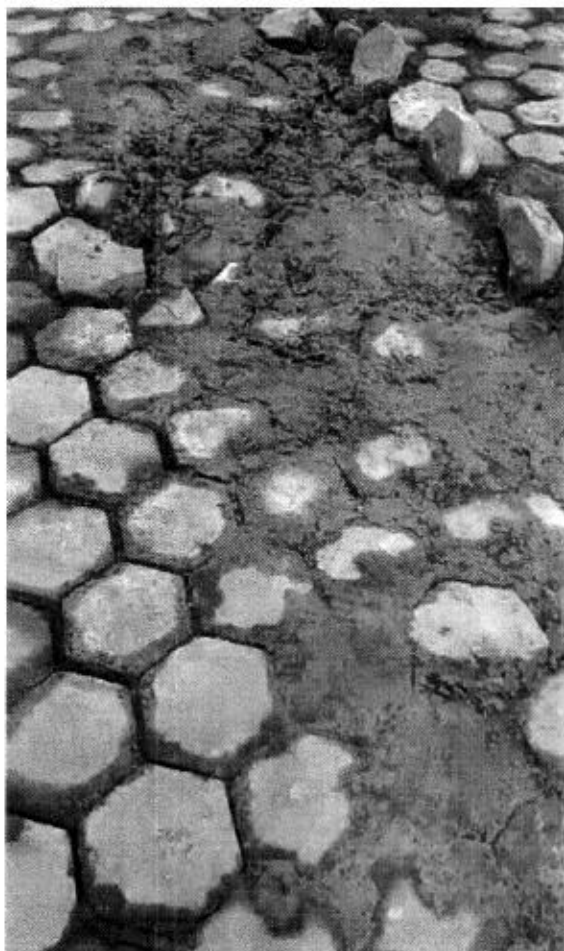
139-Reparo no calçamento Av. E, Sion
