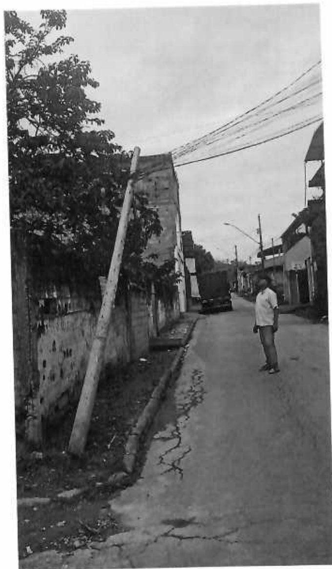
POSTE CAÍDO RUA BANDEIRANTES, Nº 146, BAIRRO SÃO JOÃO.
